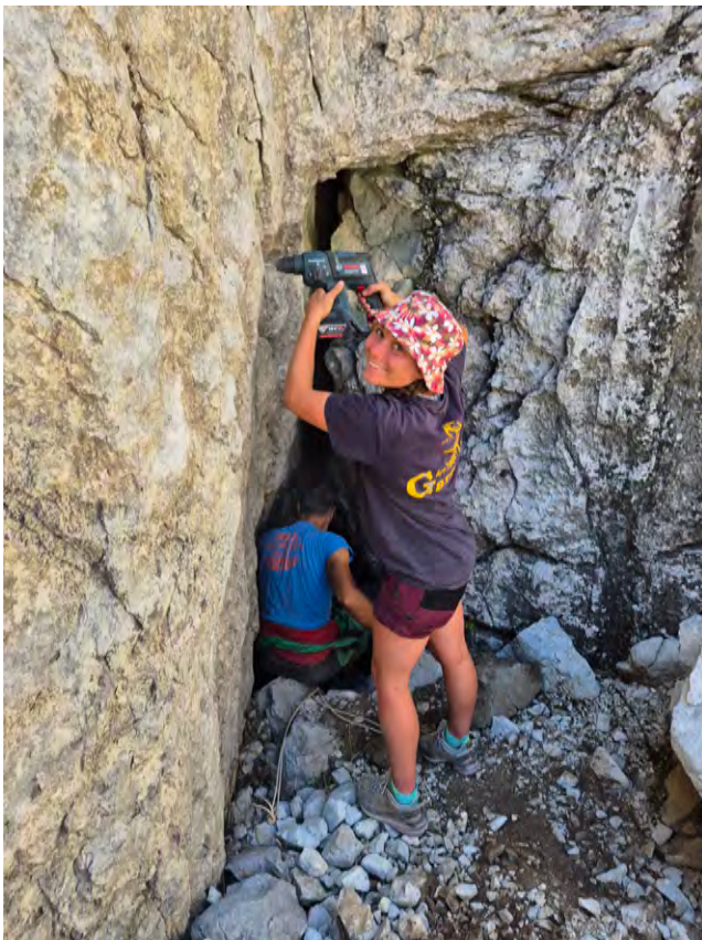
Installation d'un palan pour évacuation d'un bloc gênant
