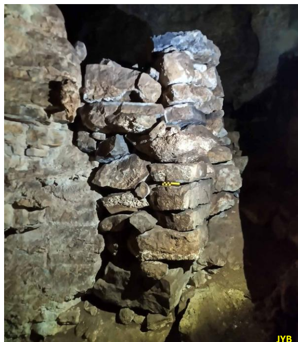
Figures 13 & 14. Un étroit passage (porte) permet d'accéder à la suite de la cavité
