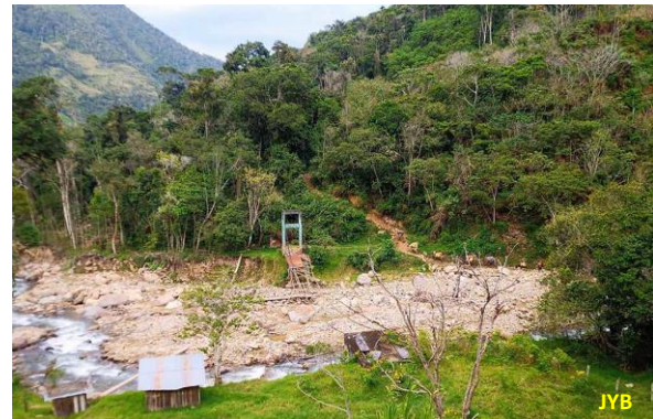
Figure 6. Le pont ruiné de la Morada
