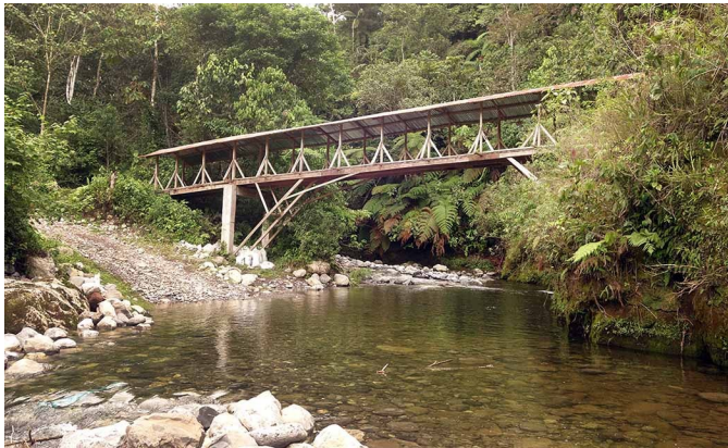
Illustration 218 – Pont sur le Río Salas, Vista Alegre, Amazonas (21-10-2022).
