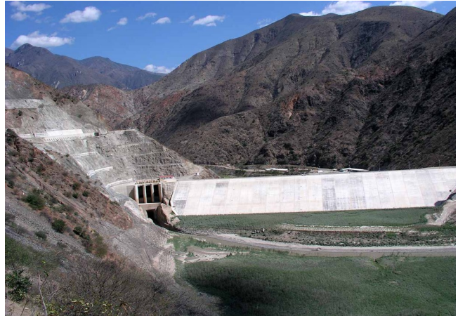
Illustration 282 – Barrage Limon sur la rivière Huancabamba, Pomahuaca, Cajamarca (31-8-2013).
